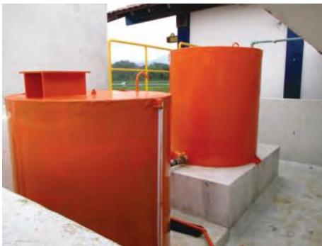
Pintura dos tanques de ácido clorídrico da ETE
