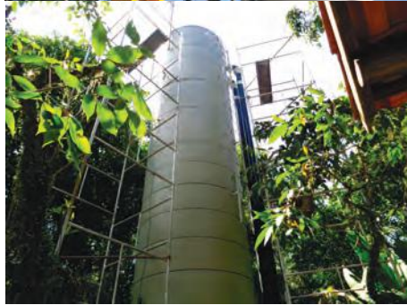
Limpeza, conservação e pintura das torres de carga e manutenção preventiva em equipamentos da Estação Elevatória de Esgoto final
