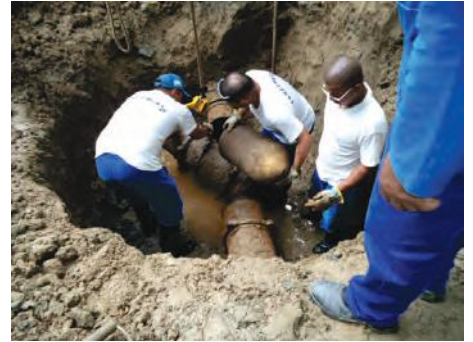
Passagem de "pig" em adutora de água bruta para melhor vazão
