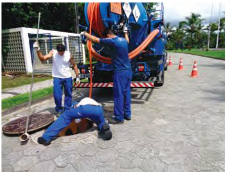
Limpeza preventiva da rede coletora de esgotos com novo equipamento da Associação dos Amigos
