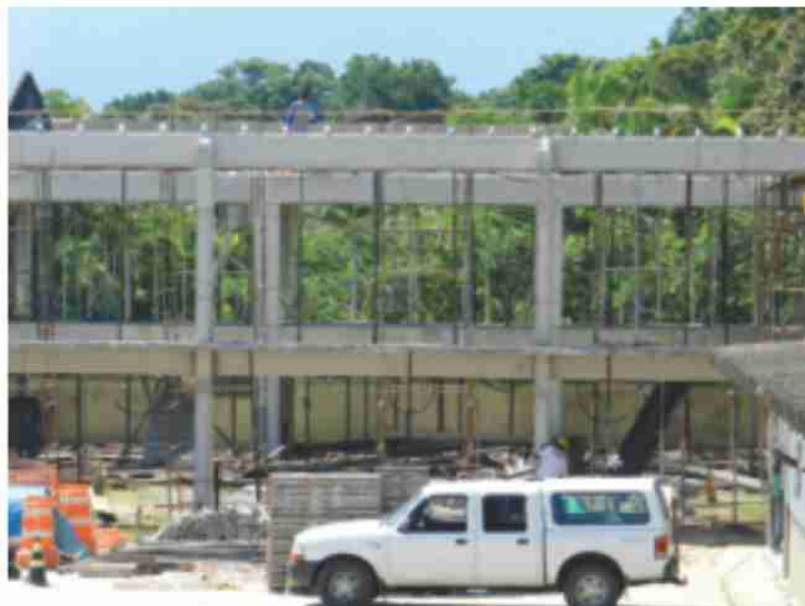
Concluída a concretagem das estruturas das instalações de ampliação da sede da ASSOCIAÇÃO.
