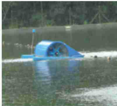
Substituição de aeradores das lagoas facultativas da Estação de Tratamento de Esgoto - ETE
