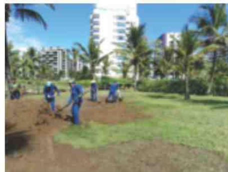
Serviços contínuos de manutenção dos módulos
