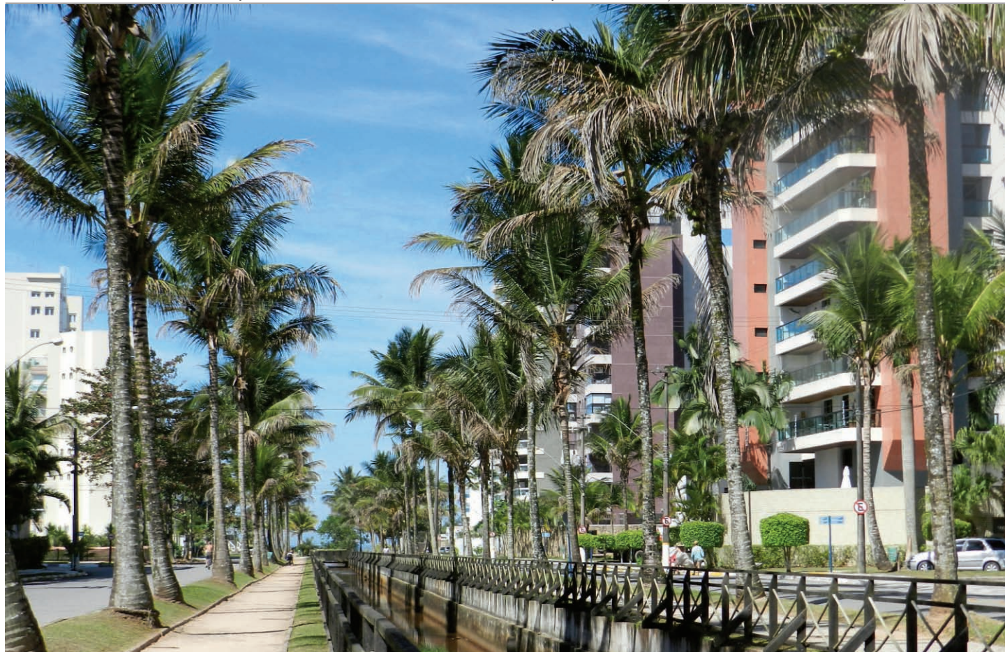
VISTA PARCIAL do Canal 2, entre os módulos 6 e 7
