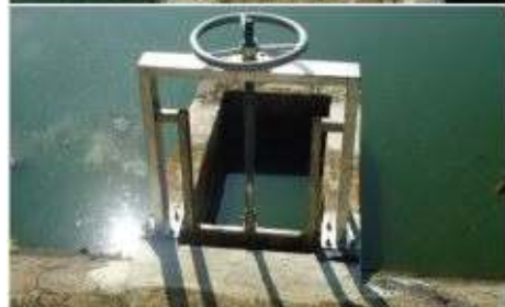
Instalação de nova comporta na lagoa de maturação da ETE
