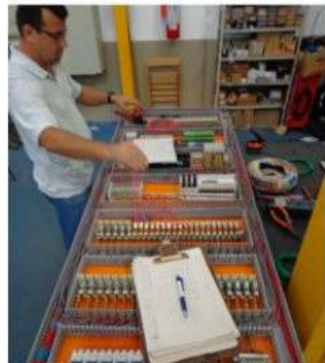
Construção de Painel Programável da Estação Elevatória de Esgoto
