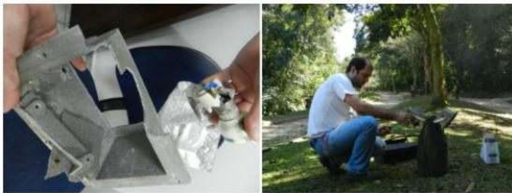
Reparos aos danos na iluminação de ciclovias, causados por vandalismo
