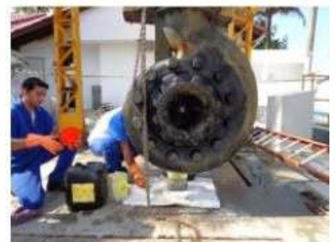
Manutenção em bombas da Estação Elevatória de Esgoto (Final e de Despejo)
