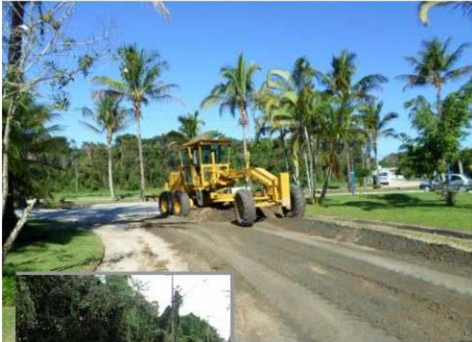
Manutenção de ruas e avenidas: reparos em pavimento e colocação de bica-corrida em pistas não pavimentadas
