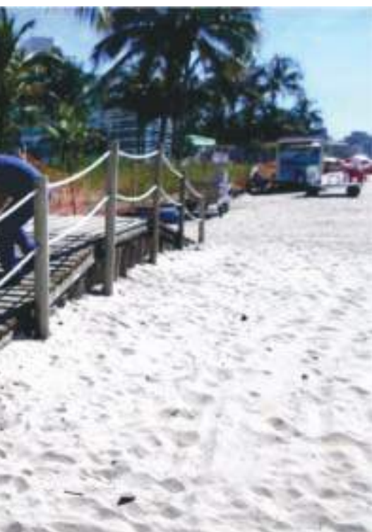
primeiro trecho da obra de recuperação da parte
