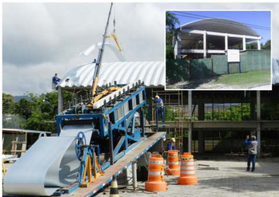
A previsão de conclusão da obra, iniciada em outubro passado, é de 12 meses.
