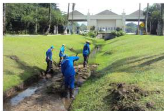
Limpeza manual e mecanizada em canais de drenagem
