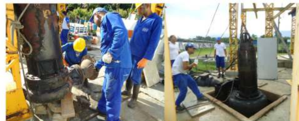
Manutenção da bomba 02 da Estação Elevatória de Esgoto Final
