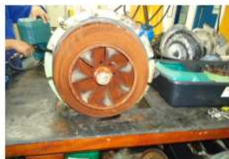
Substituição do propulsor, rolamento e selo mecânico da bomba de recalque da ETA
