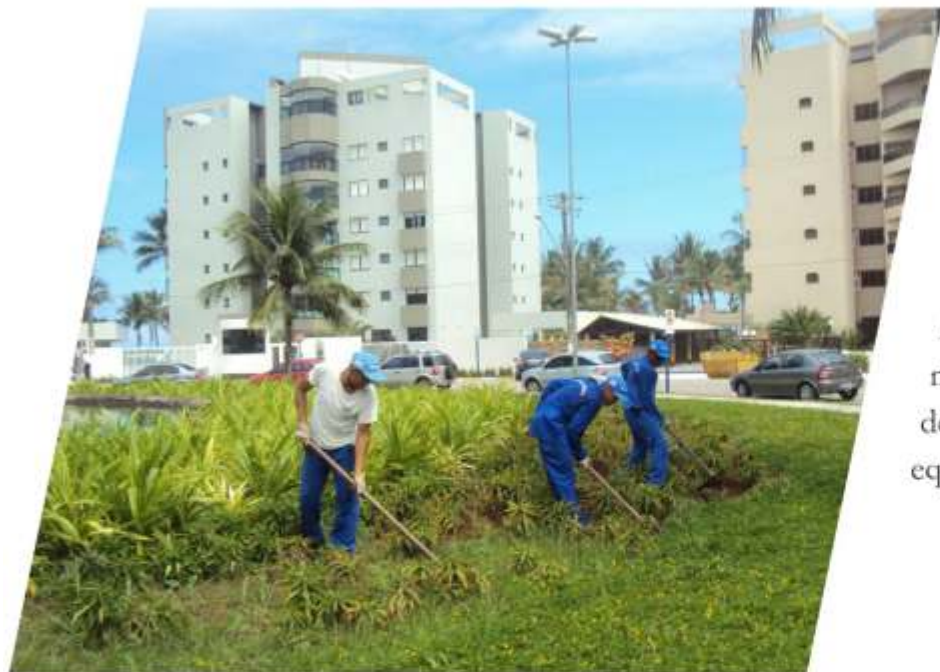
Manutenção de canaletas de drenagem e canteiros
