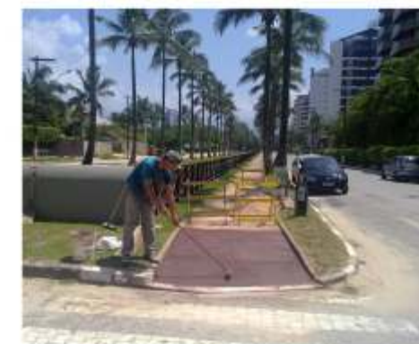
Construção de piso de concreto nos acessos às ciclovias do canal 3, módulo 6
