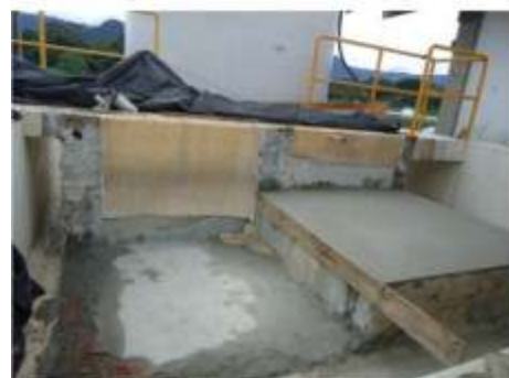
Reforma do dique de contenção do tanque de ácido clorídrico da ETE; e adquiridos dois novos tanques de polipropileno para preparo e dosagem do produto
