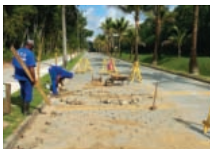
Ruas, calçadas e drenagem públicas em manutenção permanente
