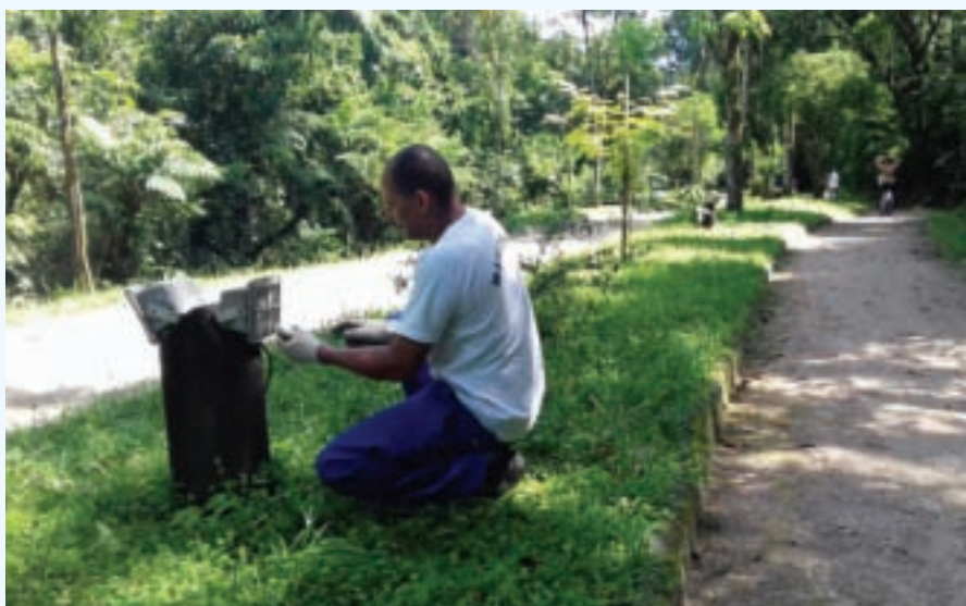
Reparos na iluminação balizadora nas ciclovias
