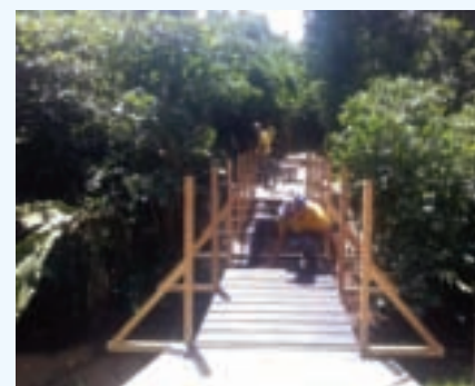
Construção de pontes de madeira
