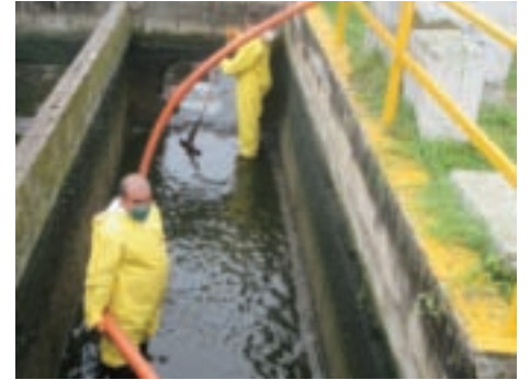
Remoção do lodo e limpeza da câmara de contato de cloro da ETE
