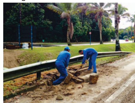
Reparos em guias e sarjetas
