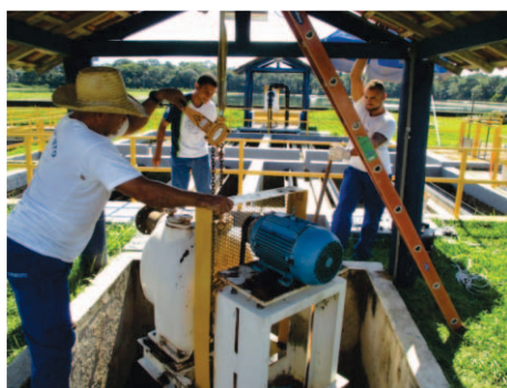
Manutenção em bomba do removedor de algas na ETE
