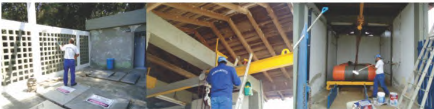
Pintura nas Estações Elevatórias de Esgoto (EEE), conservação da monovia e cilindros de cloro
