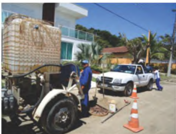
Limpeza preventiva anual da rede coletora de esgotos
