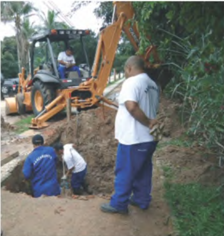
Reparo em vazamento de rede de água, na Av. São Lourenço
