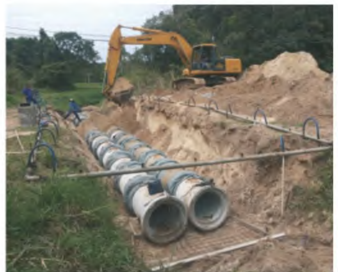
Drenagem do Canal da Orla, entre os Módulos 8 e 21
