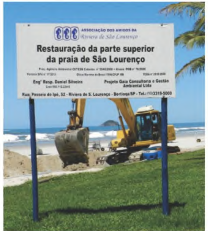
Obra restaura trechos da praia atingidos por ressacas
