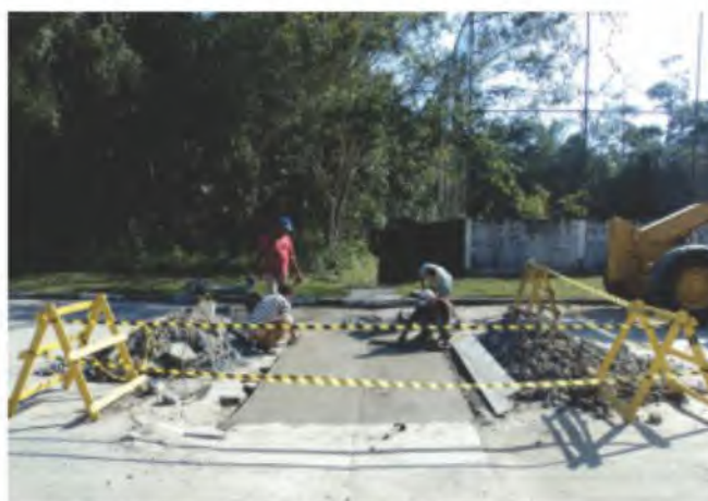
Reforma de sarjetão no Módulo 26
