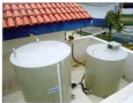
Instalação dos tanques de preparo e dosagem de ácido clorídrico da ETE
