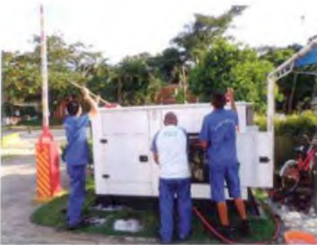
Manutenção preventiva no gerador do prédio sede da Associação dos Amigos
