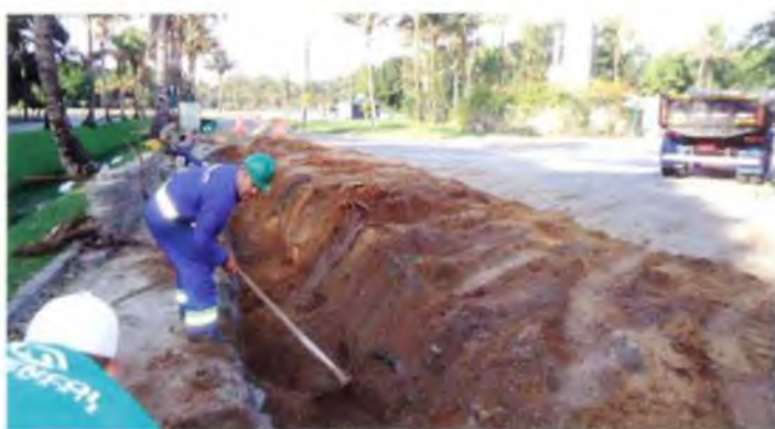
A ASSOCIAÇÃO DOS AMIGOS DA RIVIERA está acompanhando os serviços que empresas empreendedoras do Jardim São Lourenço e a Sabesp executam para construção de rede que receberá o esgoto gerado pelo bairro vizinho. Trata-se de rede e sistema totalmente independentes e não fazem parte do projeto da Riviera. Sua operação e manutenção serão realizadas exclusivamente pela Sabesp. A rede se inicia em um ramal no Jardim São Lourenço, seguindo pelas vias públicas da Riviera até se interligar a uma rede de esgoto no Jardim Indaiá. Desse ponto, a obra seguirá até uma Estação de Tratamento de Esgoto da Sabesp, localizada no loteamento Chácaras Vista Linda.
