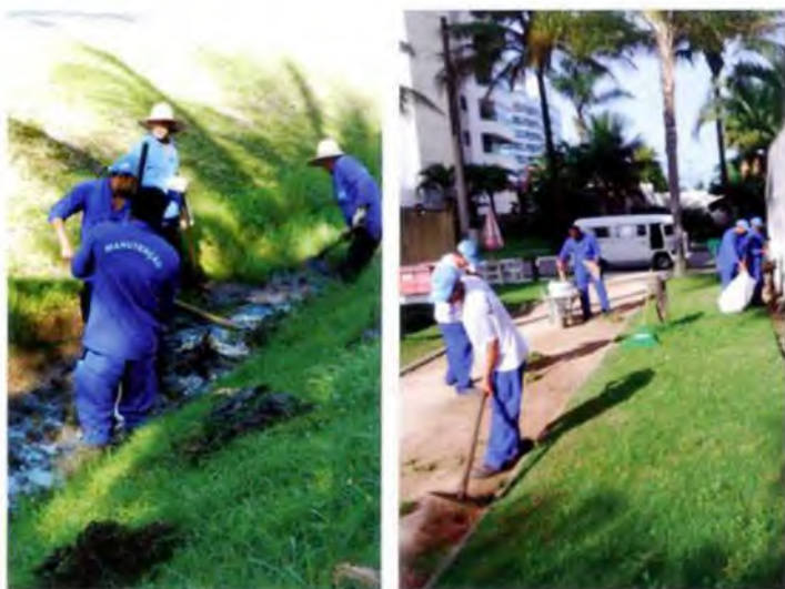
Canais de drenagem e passagens de pedestres recebem serviços periódicos de limpeza e roçadas
