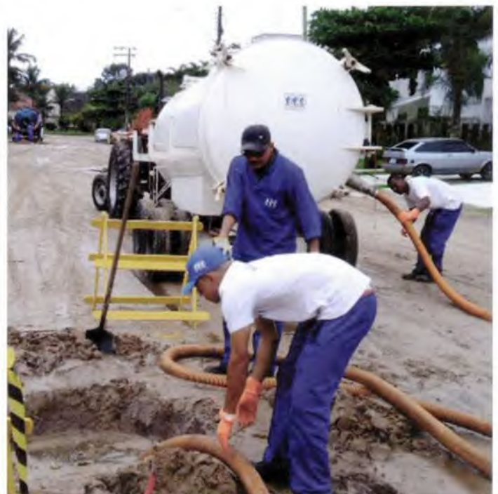
Desobstrução de rede de esgoto e manutenção preventiva
