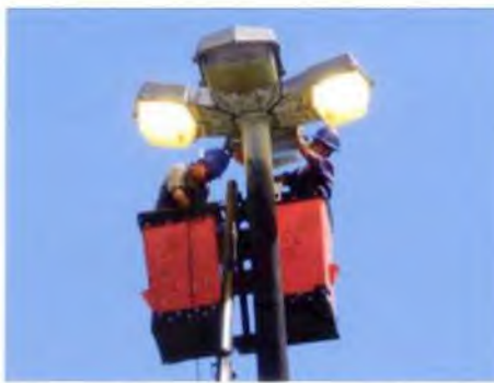
Substituição de luminárias dos postes altos da Av. Riviera e no trevo de acesso
