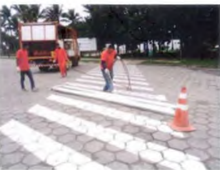
Manutenção de ruas e avenidas e pintura de faixas de pedestres
