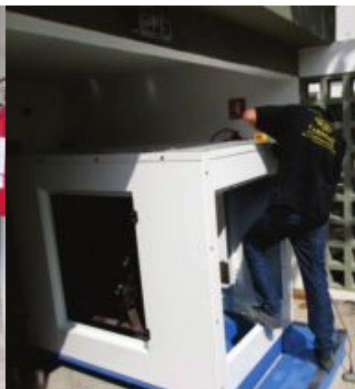
Readequação de Estação Elevatória de Esgoto e isolamento acústico do gerador
