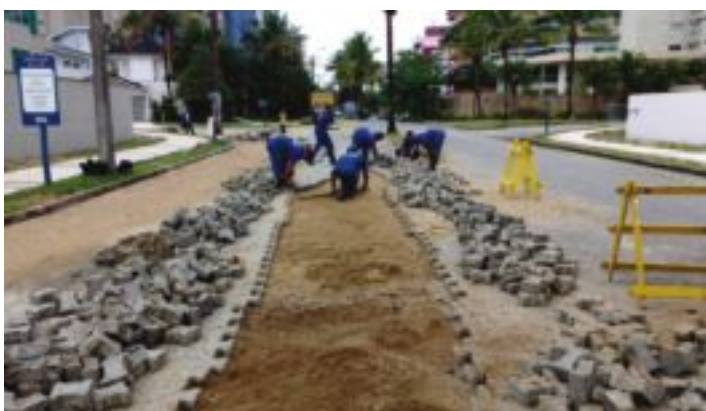
Reforma nos pavimentos de Alamedas e Avenidas
