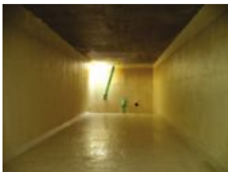
Higienização e desinfecção dos reservatórios de água são realizados por empresa especializada.
