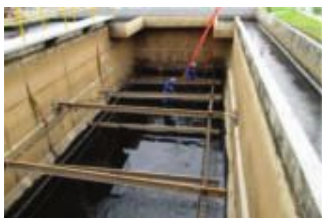
Limpeza do tanque na Estação de Tratamento de Esgotos para substituição de peças da corrente e raspador
