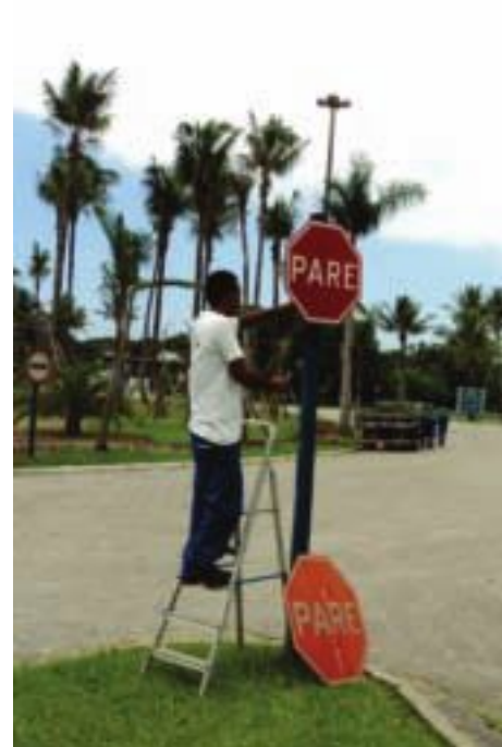
Manutenção da sinalização viária
