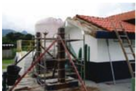
Obra para abrigo de bombas dosadoras na Estação de Tratamento de Esgoto (ETE)
