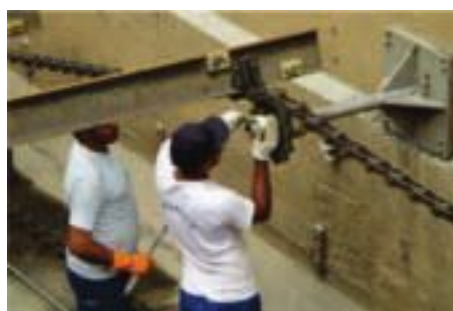
Limpeza do tanque na Estação de Tratamento de Esgotos para substituição de peças da corrente e raspador
