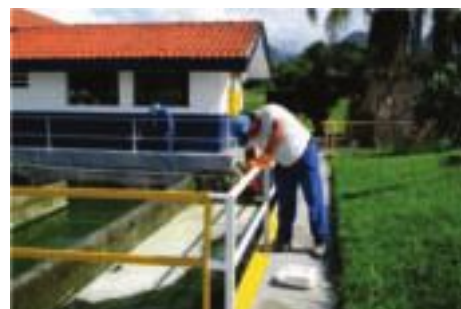
Instalação de guarda-corpo na ETE para proteção de funcionários e visitantes nas instalações de saneamento
