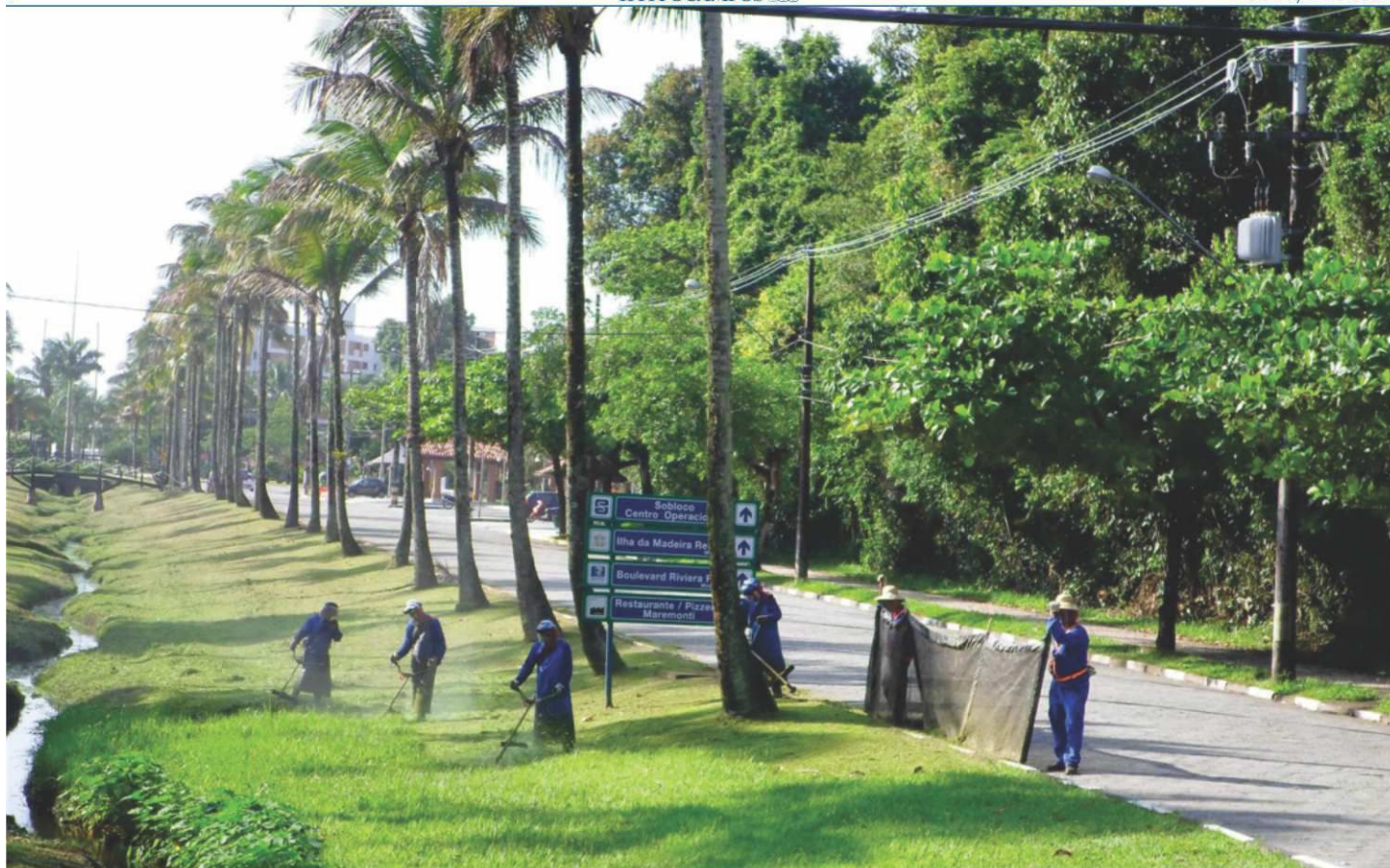
Roçada no canal da Avenida Riviera
