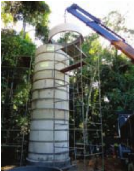
Demolição e reconstrução da torre de carga do Módulo 28
