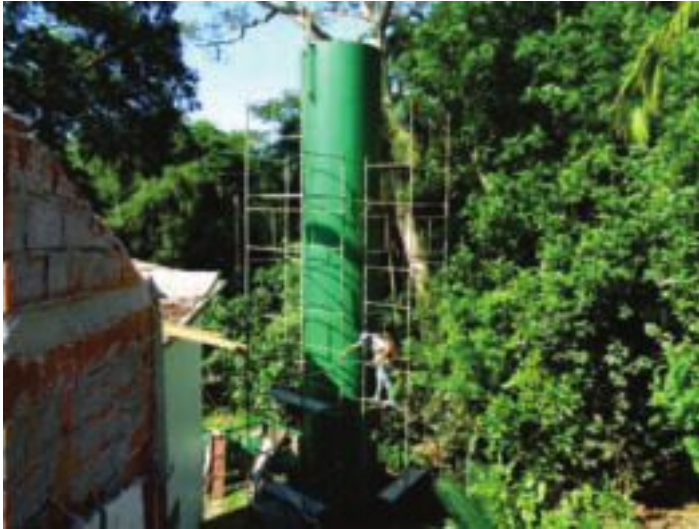
Pintura na (rede) linha de água bruta na EBAR e na entrada da ETE
